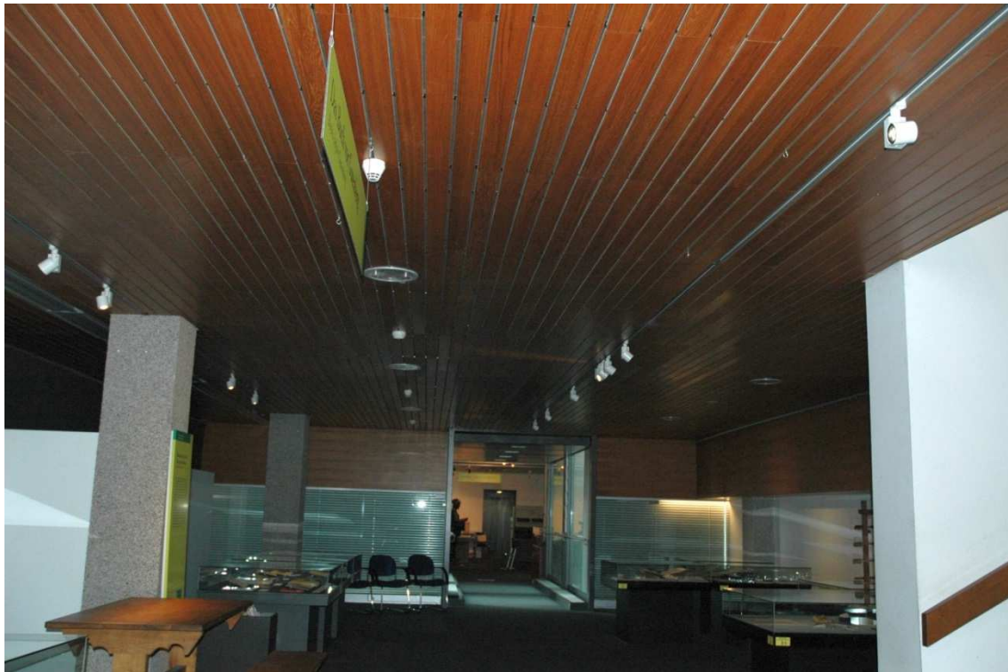
Abbildung 3: Die neuen LED-Strahler über der Ausstellungsfläche „Richtung Asien“ im Gutenberg Museum. Quelle/ Foto Amt: 451
