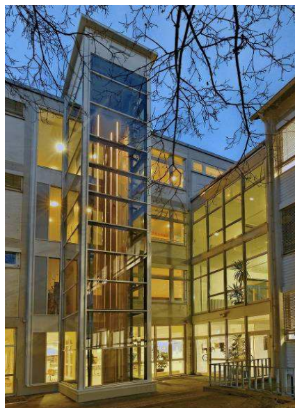
illuminerte Aufzugsanlage Bildquelle: © Fotograf Langer
