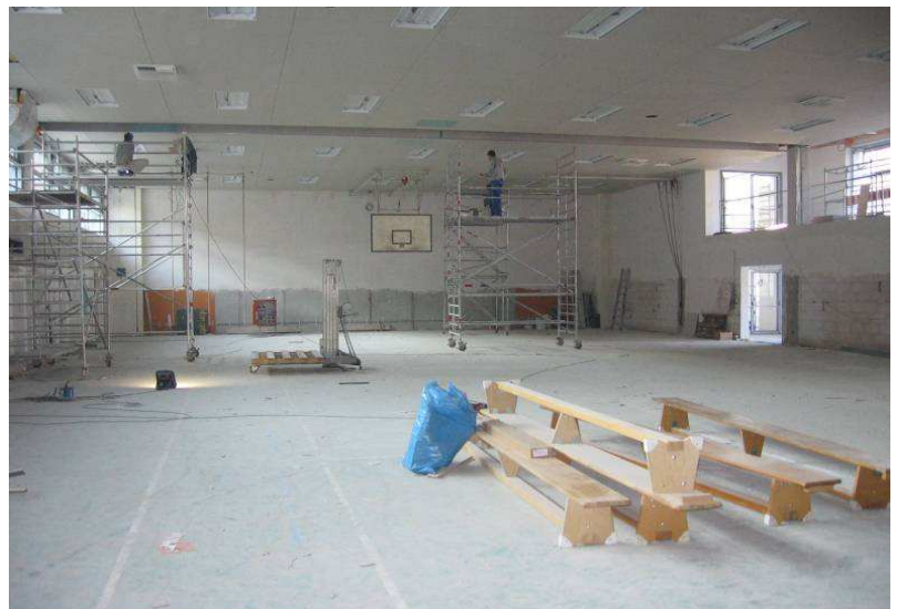
Arbeiten an der Akustikdecke
