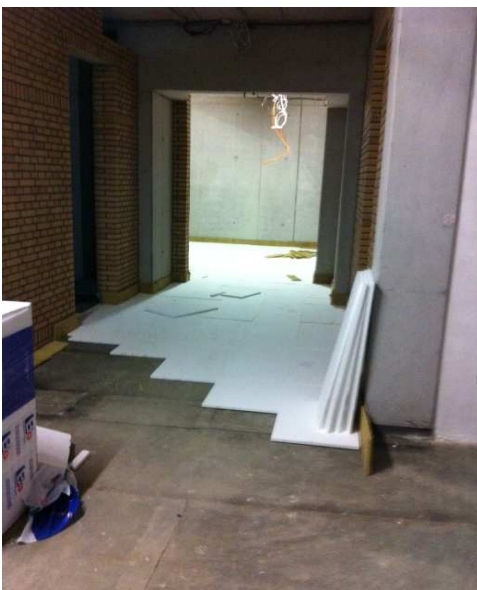
Estricharbeiten im Kellergeschoss
